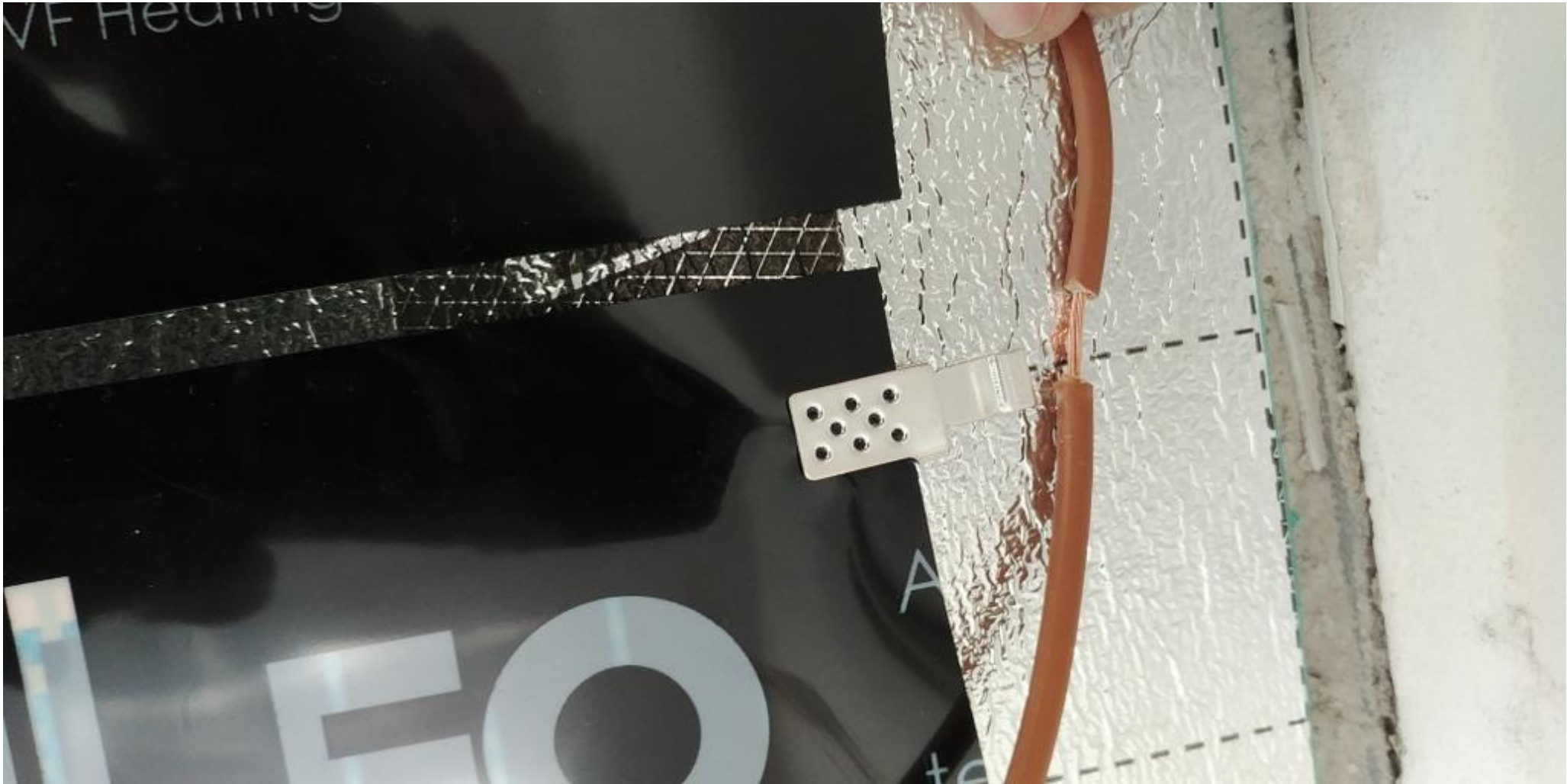
Eemalda kaablilt isolatsioon
